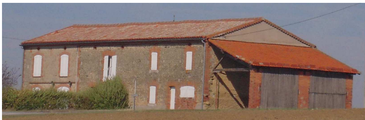
Source : Interfaces + - Bâti ancien isolé à Borde Neuve
