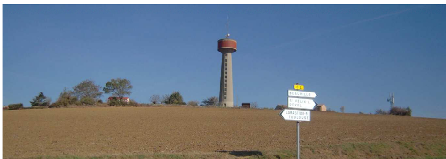
Source : Interfaces + - Vue sur le hameau de la Tour depuis la D2
