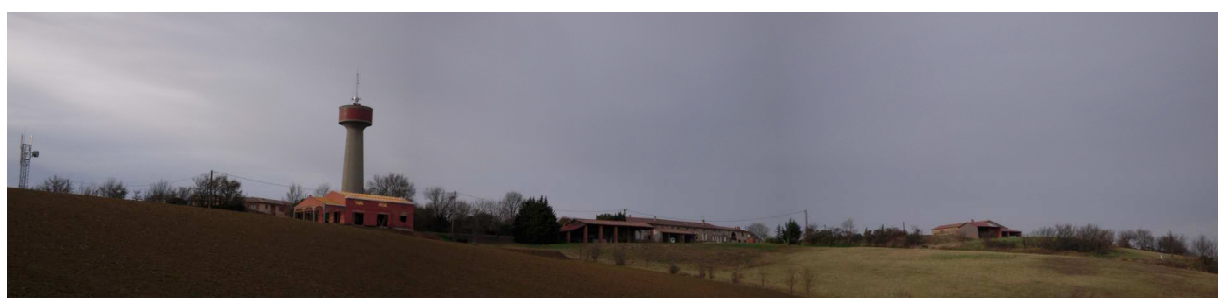
Source : Interfaces + - Vue sur le hameau de la Tour depuis la D2
