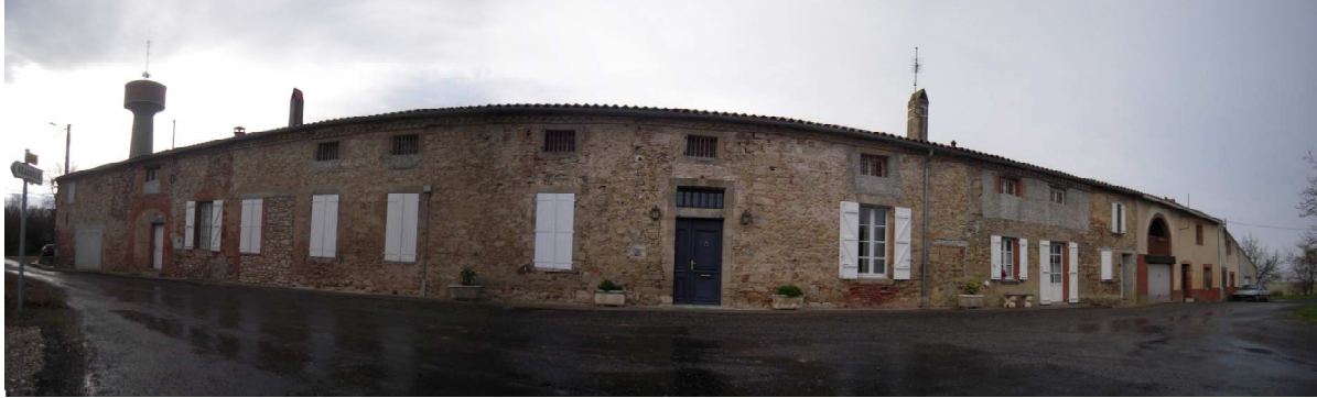
Source : Interfaces + - Bâti ancien à La Tour
