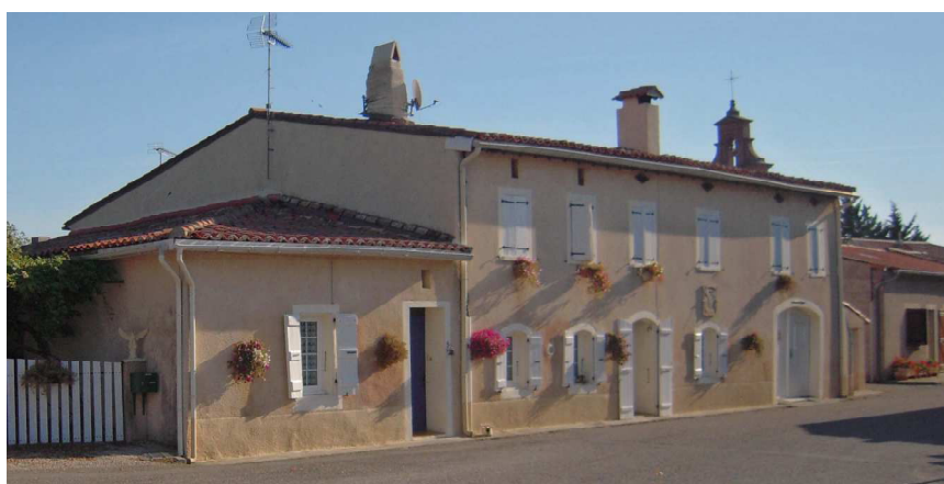
Source : Interfaces + - Maisons à architecture "toulousaine" dans le centre bourg
