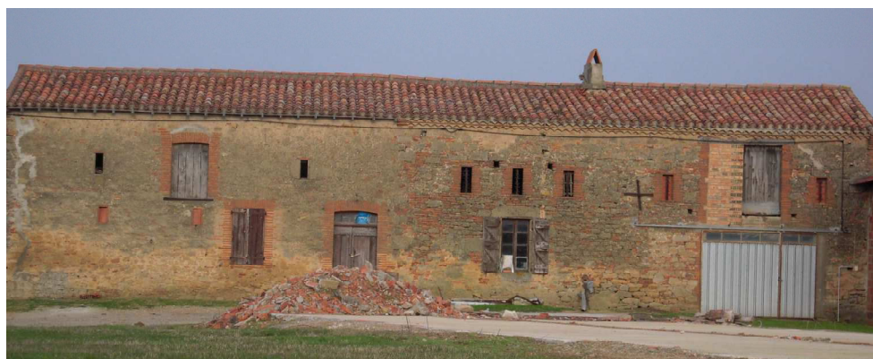
Source : Interfaces + - Bâti ancien à la Tour
